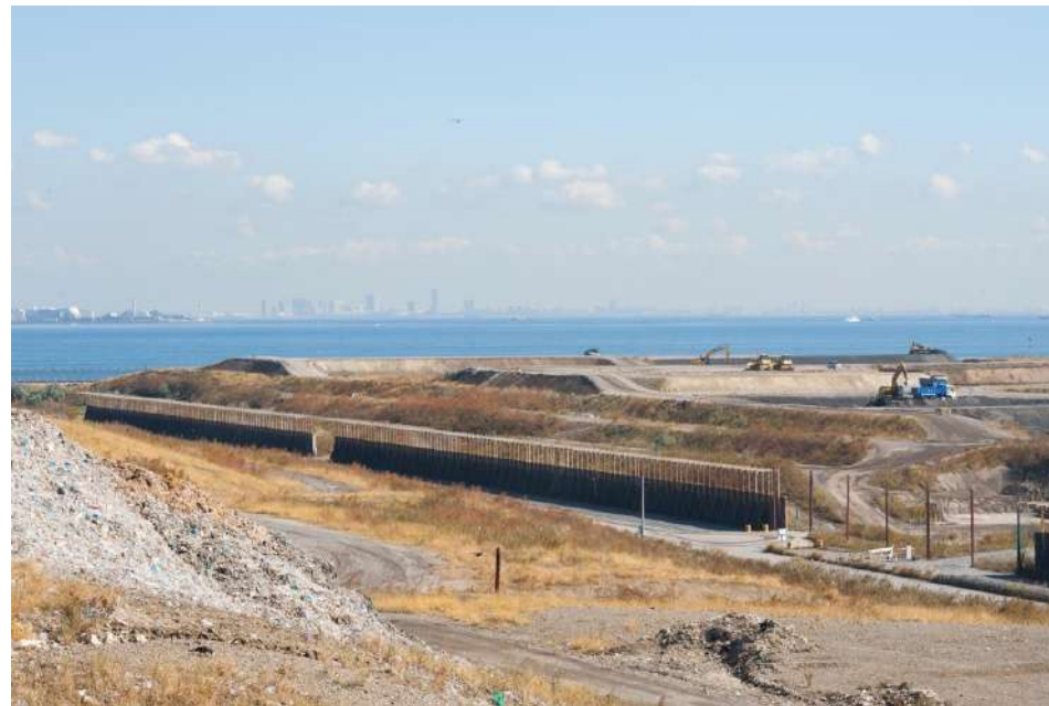
東京都江東区の新海面処分場
